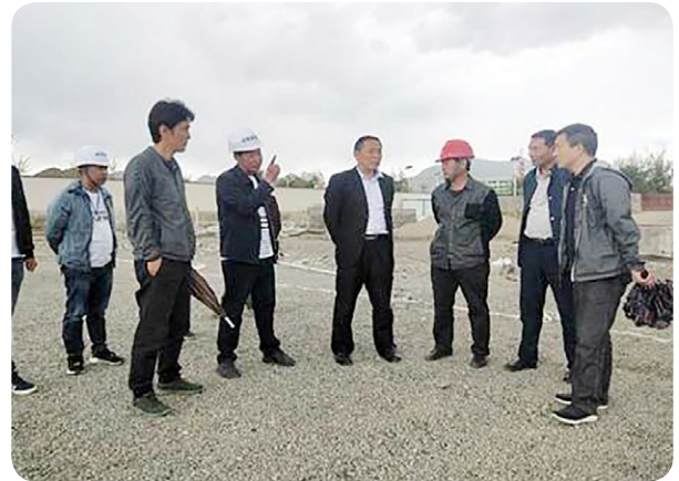
西藏自治区工信厅副巡视员肖烟（左五）调研日喀则市 I 级无线电监测站工程建设情况。
